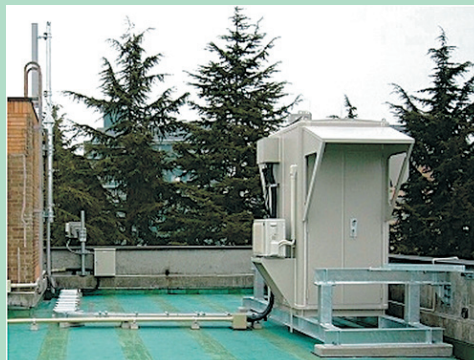
MBWA 実証実験 (基地局設備)
