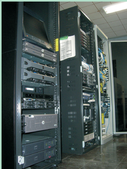
ネットワーク機器室
