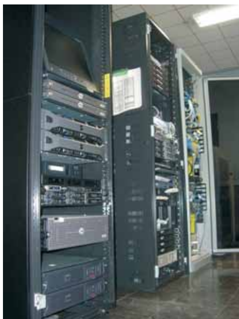
ネットワーク機器室 Network room
