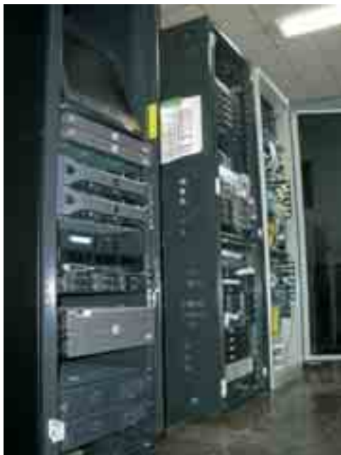
ネットワーク機器室 Network room
