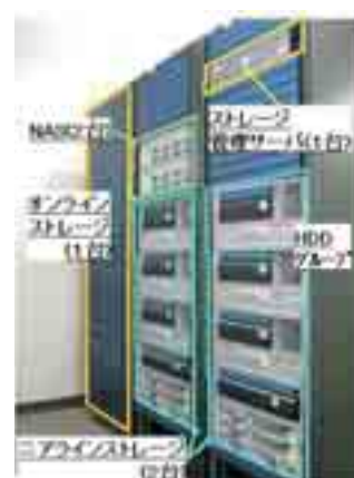
図2 多数の並列HDDにより構成される大規模ストレージシステム Fig. 2 A large-scale storage system with parallel HDD operation.
