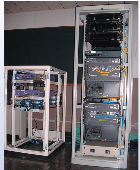
ネットワーク機器室
