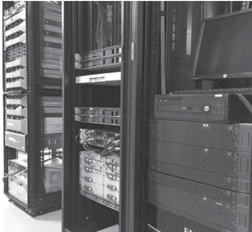
図1 電気通信研究所サーバールームの様子
