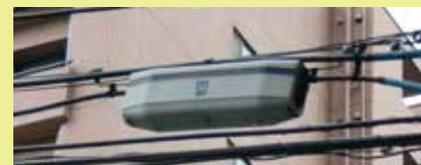
図1 身近で確認できる光クロージャの例
